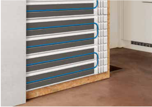
38. Ábra KAN-therm TBS 16 tábla acél hőszigetelő lécekkal.
